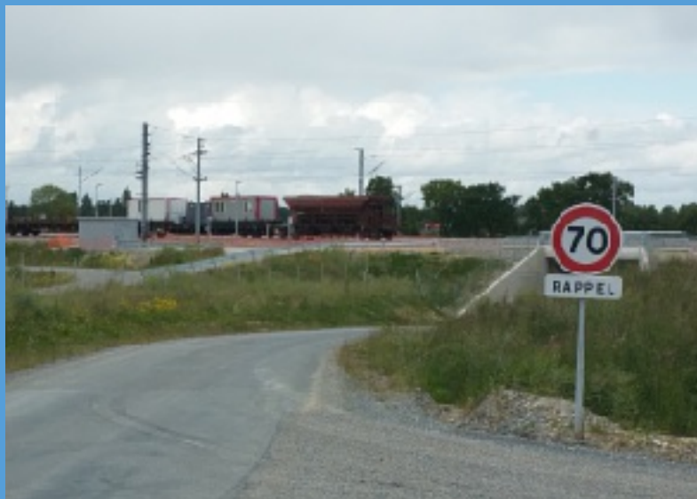
Travaux et ouvrages d'art / raccordement Argentré Laval.
