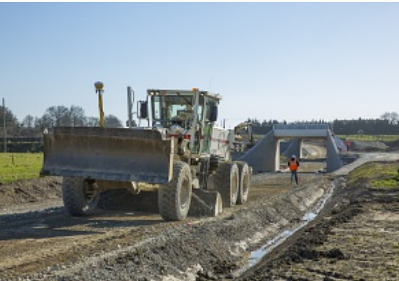
Photos du chantier à Argentré, source Eiffage
