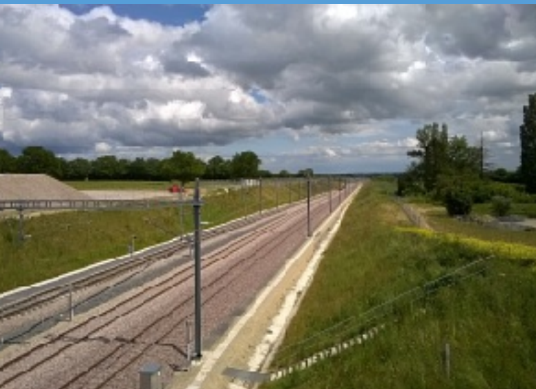
Vue d'une partie de la ligne à Argentré.
