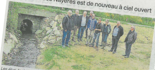
Les élus, techniciens et chefs d'entreprises devant l'ouvrage qui permet au ruisseau de passer sous la route.
