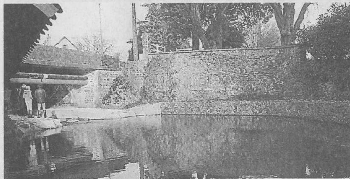
On distingue sous le pont, la saignée centrale du ravier, et les fameuses cages à pierres, devant le mur d'un riverain.
