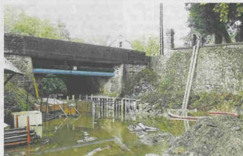
Les responsables du syndicat ont pu constater les dégâts.
