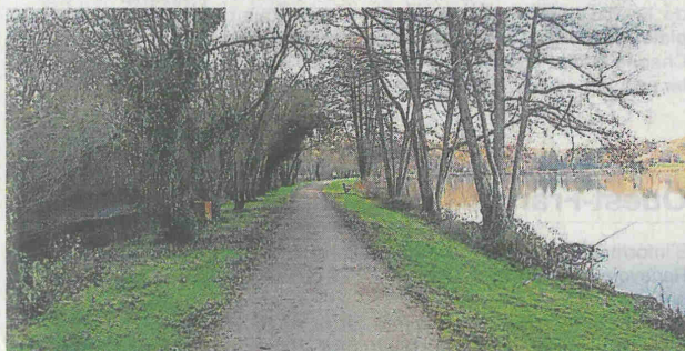
La digue va être totalement refaite.
