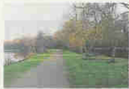
La digue va être totalement refaite.
