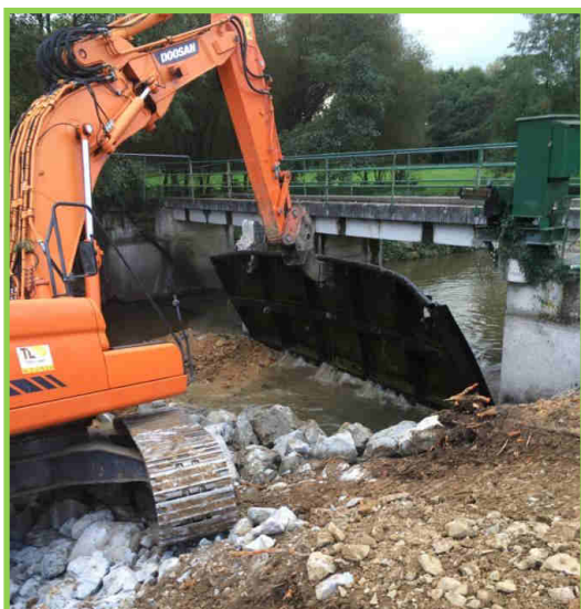
Suppression du barrage
